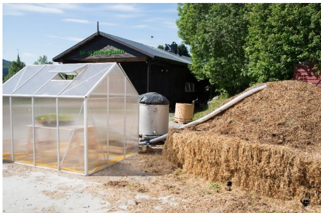
Bilde 6: Biomile bygges opp med ferskt organisk materiale som utvikler varme som transporteres til drivhus med vann som pumpes ditt i innlagte vannslanger. Foto: Joshua Cabell.
