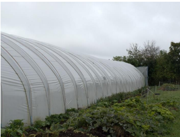
Bilde 1: Tunellformet takkonstruksjon gjør at snøen ikke blir liggende. Foto: Susanne Friis Pedersen.
